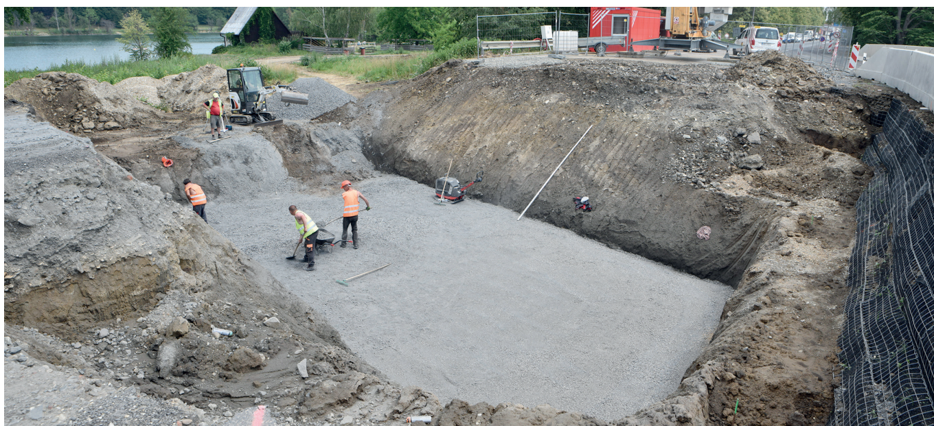
Pro vaše bezpečí stavíme pod Rolnickou nový podchod.
